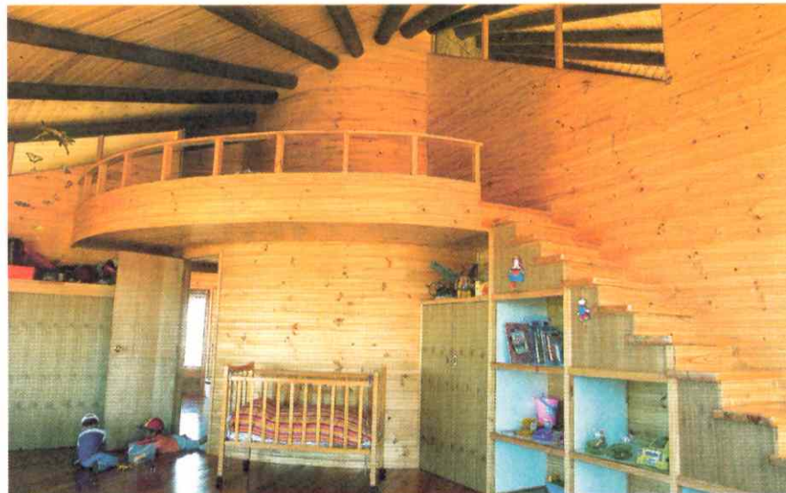
EN LA PIEZA DE LOS NIÑOS se aprecia la curva que hacen las vigas y la existencia de muros radiales que no llegan hasta arriba.
